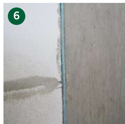
Vid ljudkrav monteras multiplattan mot en ljuddämpande remsa typ Geficel PE-folie.
