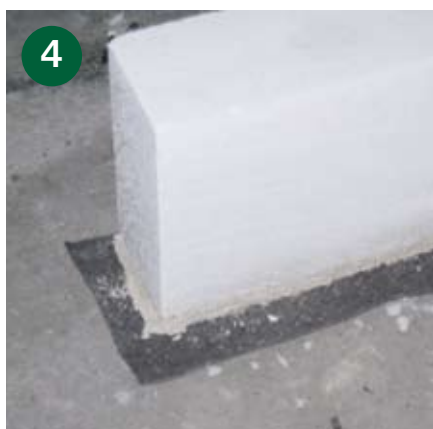
Vid risk för fukt från betongplattan monteras multiplattan på asfaltpapp.
