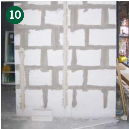
Elektriker markerar på multiplattan innervägg var elledningen ska vara. Byggtreprenör, elektriker eller multiplattan-montör spårar och lagar.
