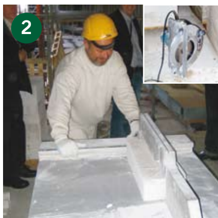
Multiplattan kapas med en cirkelsåg eller på ett sågbord anpassat för multiplattan.
