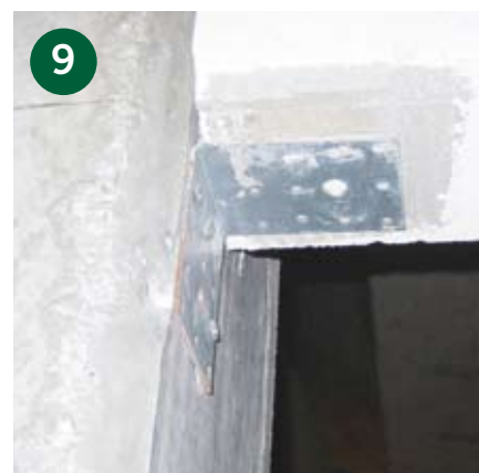
Upplag på vinkelstål för balkar vid anslutande betongvägg.
