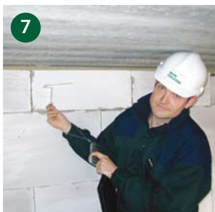
Multiplattan förankras i ovkant med ett fjäderbeslag. Fogskum sprutas in från båda sidor.
