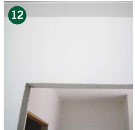
Väggen är målad och klar. Mjukfog i takvinkeln...
